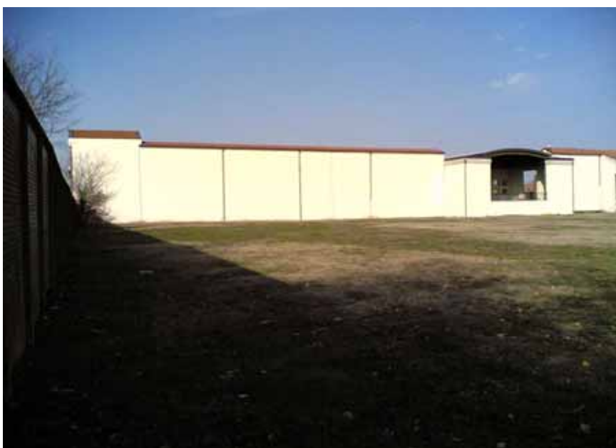
Vista dall'attuale recinzione di confine posta a sud; sulla destra il passaggio ad arco esistente che verrà integrato nel nuovo progetto
