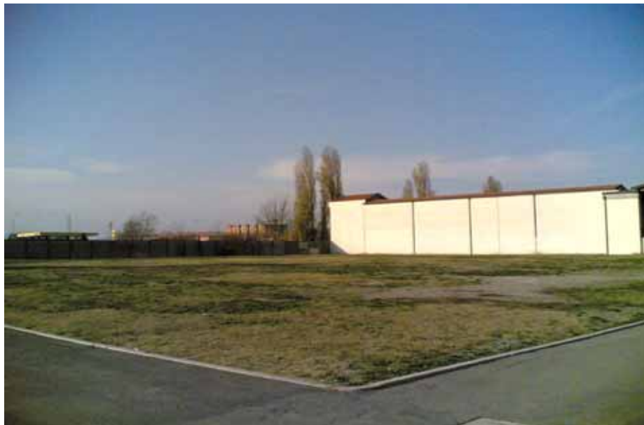
Vista da est del lotto d'intervento: sullo sfondo l'edificio esistente e il muro di recinzione.
